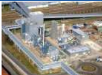
Vattenfall Schwarze Pumpe Germany - 30 MWth Oxy - Lignite
